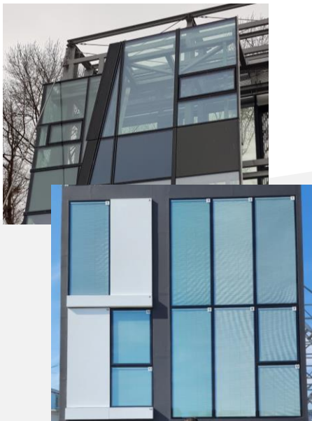
Mock-up σε φυσικό μέγεθος, στο κτίριο
